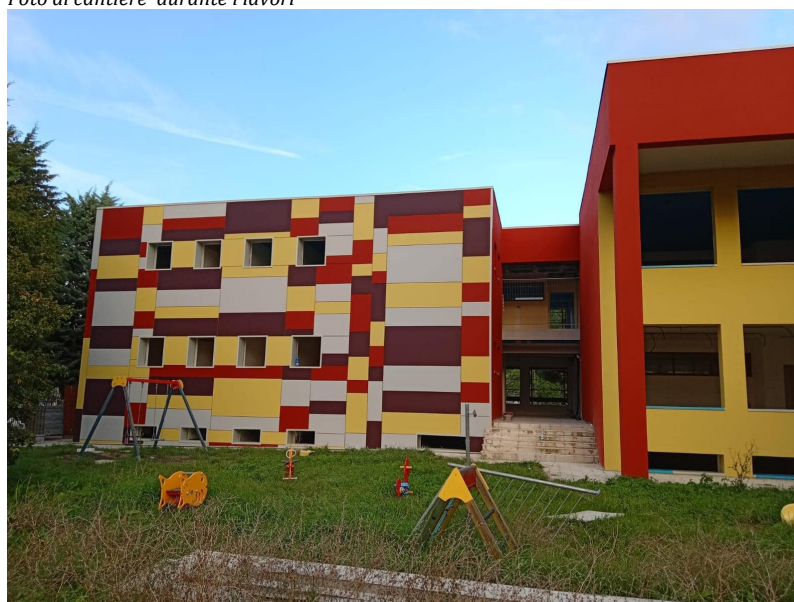
Foto di cantiere durante i lavori
