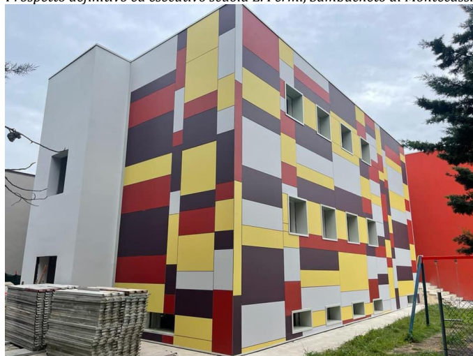
Foto di cantiere durante i lavori
