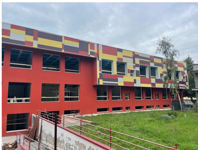
Foto di cantiere durante i lavori
