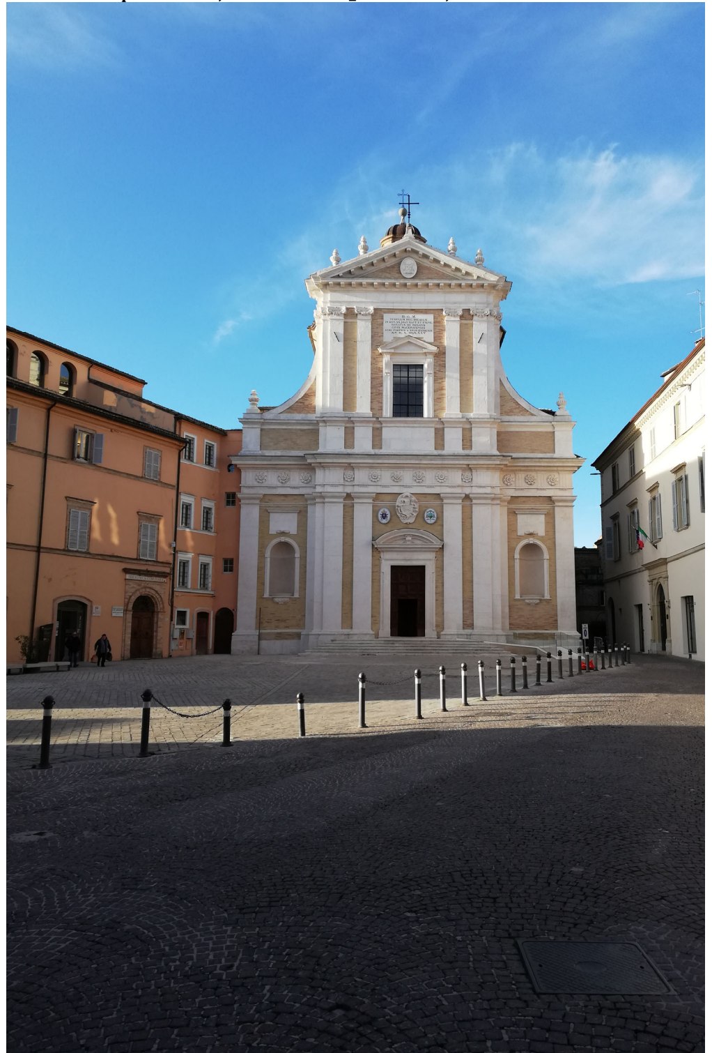
Facciata restaurata Collegiata San Giovanni
