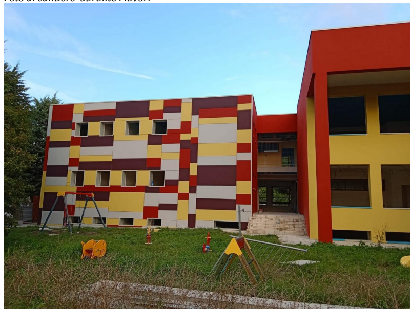
Foto di cantiere durante i lavori
