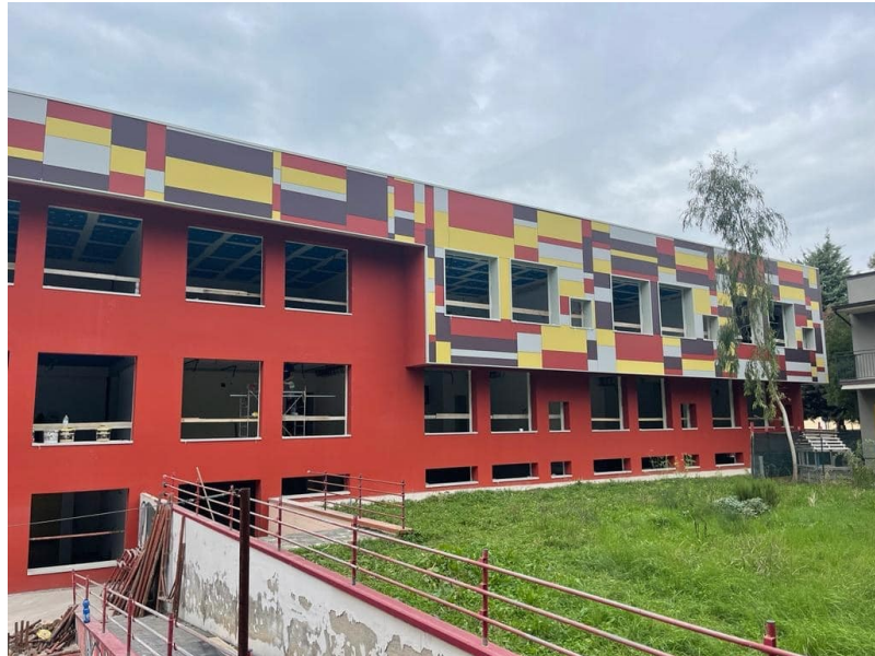
Foto di cantiere durante i lavori
