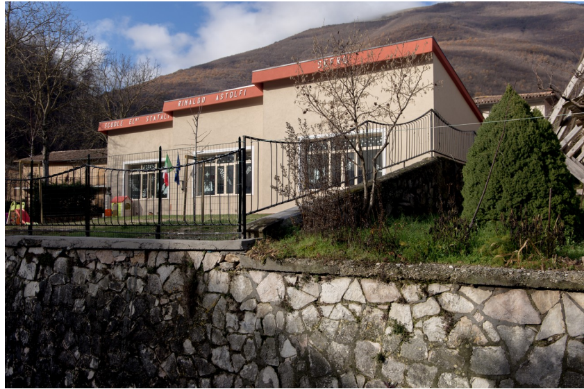
Scuola materna ed elementare di Sefro. Progetto definitivo- esecutivo e direzione lavori.
