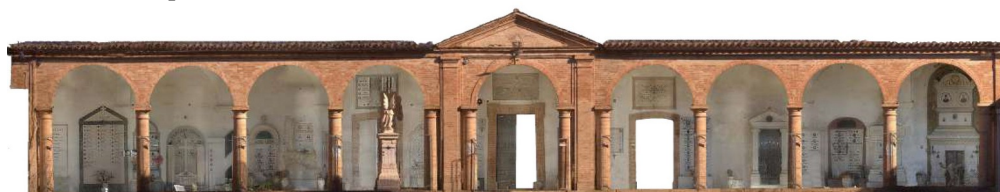
Riparazione danni e risanamento conservativo Loggiato storico Civico Cimitero Penna San Giovanni. Progetto definitivo. Esecutivo in corso.
