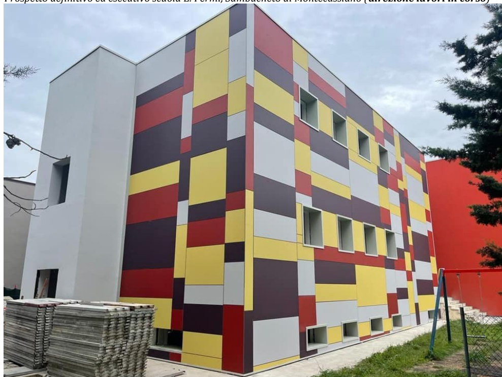
Foto di cantiere durante i lavori
