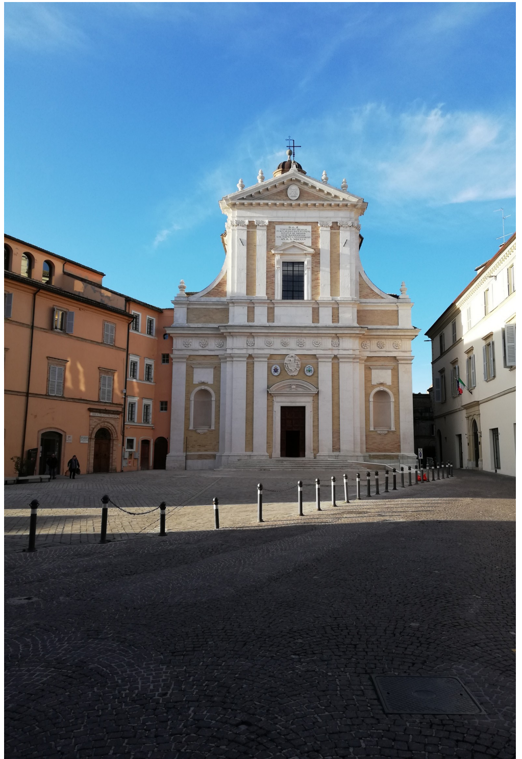
Facciata restaurata Collegiata San Giovanni
