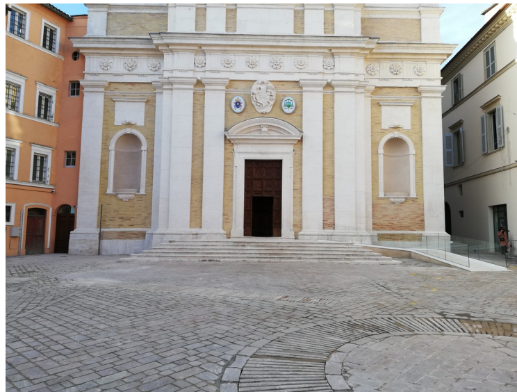
Dettaglio rampa in facciata restaurata collegiata San Giovanni
