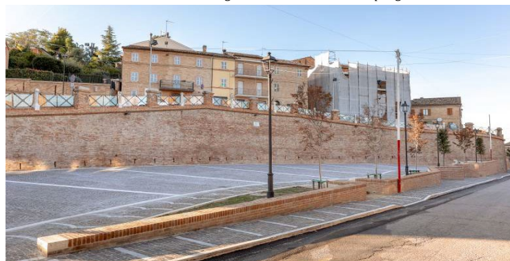
Pavimento Piazzale Trento, Sant’Angelo in Pontano. Foto prospettica
