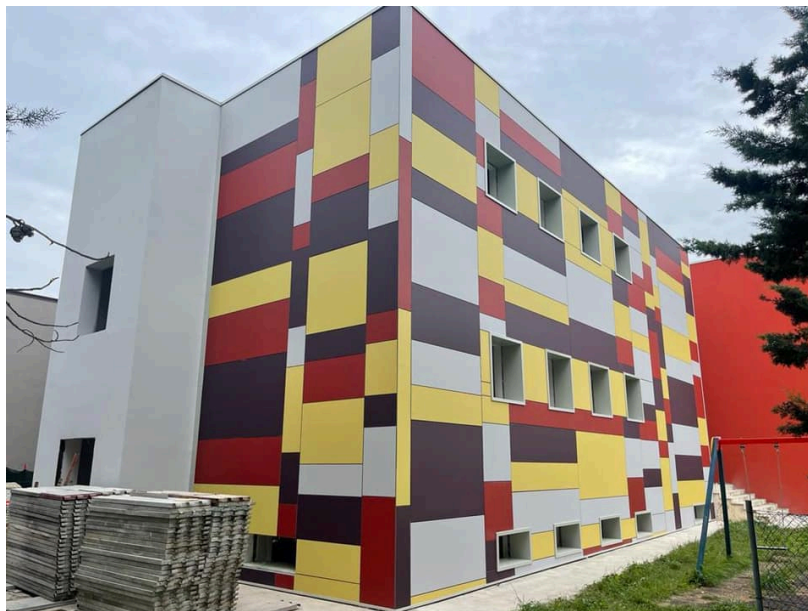
Foto di cantiere durante i lavori
