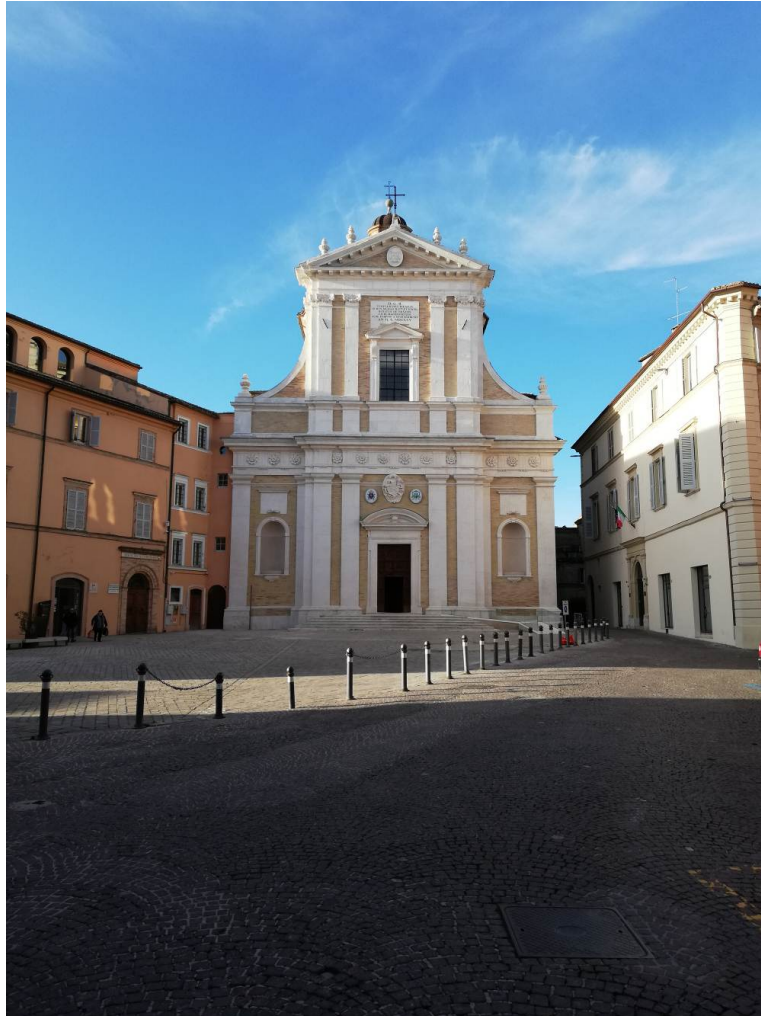
Facciata restaurata Collegiata San Giovanni
