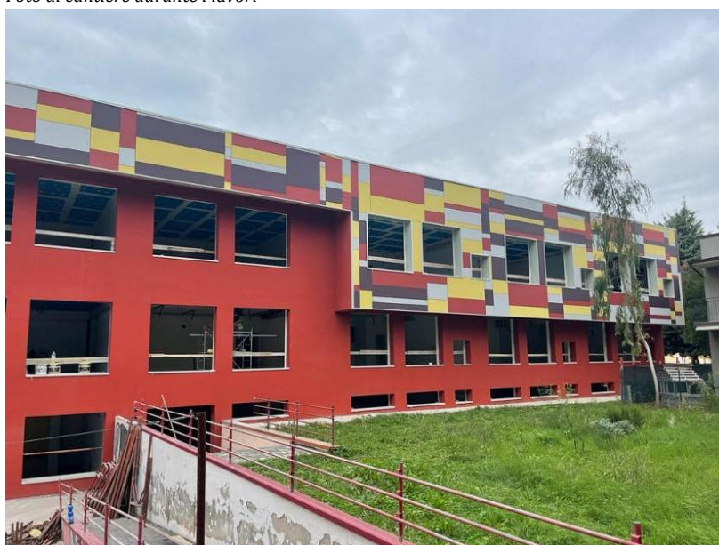
Foto di cantiere durante i lavori
