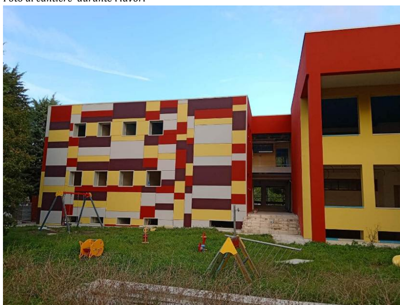
Foto di cantiere durante i lavori
